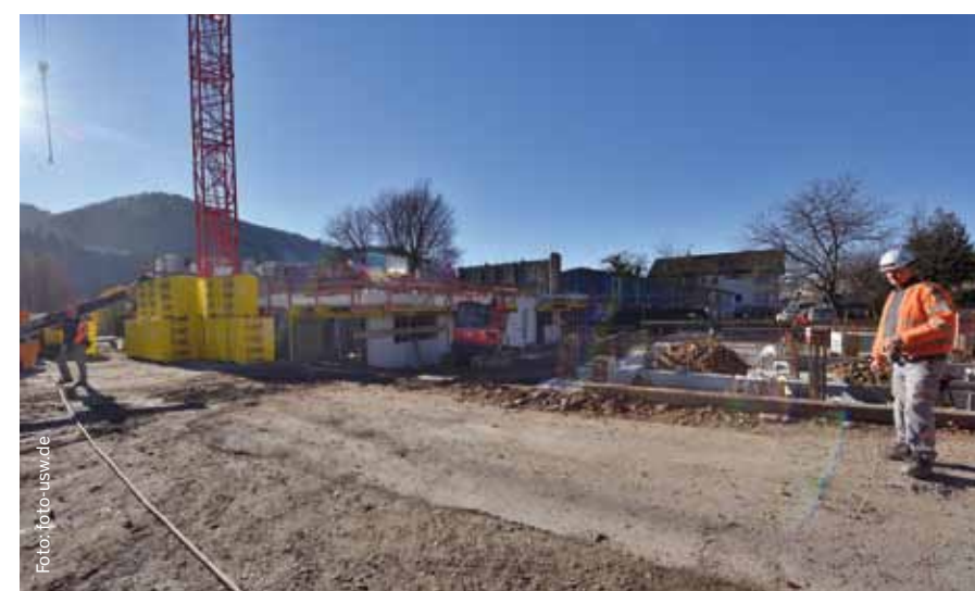
Das Neubauprojekt in Waldkirch-Batzenhäusle im November 2016
