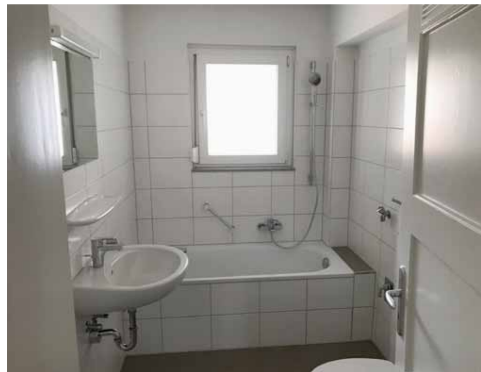
Beispiel für eine Badsanierung
